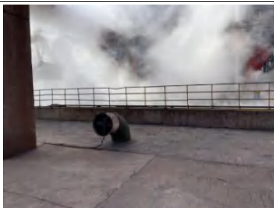
炼铁厂一次冲渣过滤池
