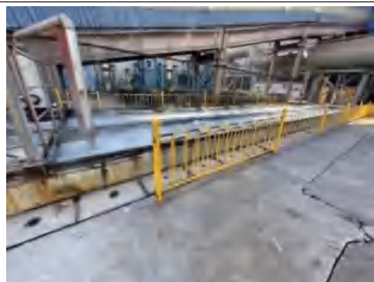
炼铁厂烧结车间石灰水池
